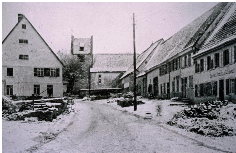
Blick von der Kirchstraße zur alten Kirche um 1910
