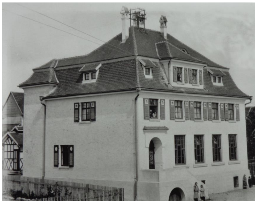
Das „Neue Schulhaus“ wie es im Jahr 1907 gebaut wurde. Aber schon 1910 kam der westliche Anbau hinzu.
